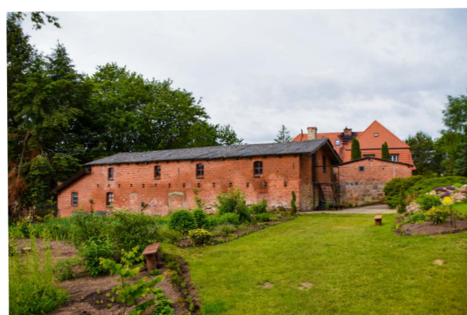
Budynki folwarku (w trakcie adaptacji), Wygoda Łączyńska, 2022
